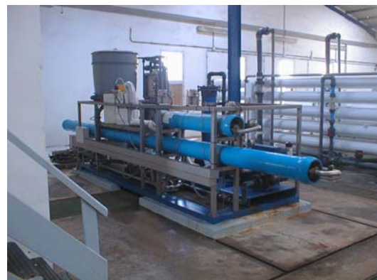
Figura 2. Fotografía de la planta.
