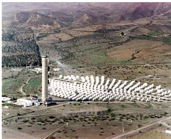
Figura 1: Sistema de Receptor Central CESA-I de PSA
